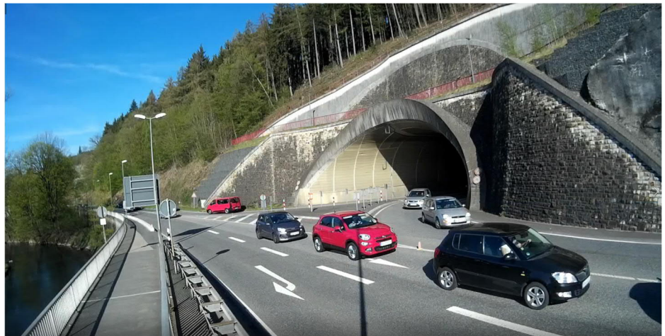
Bild B2 Beispiel: Rückstau am nördlichen Tunnelportal um 17:27 Uhr
