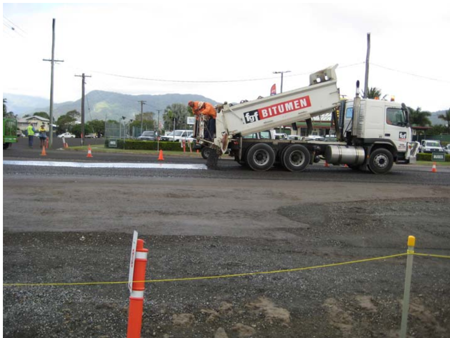
Bild 2121 Versiegelung der Oberfläche der KRC-Schicht - Abstreuen der angespritzten Oberfläche
