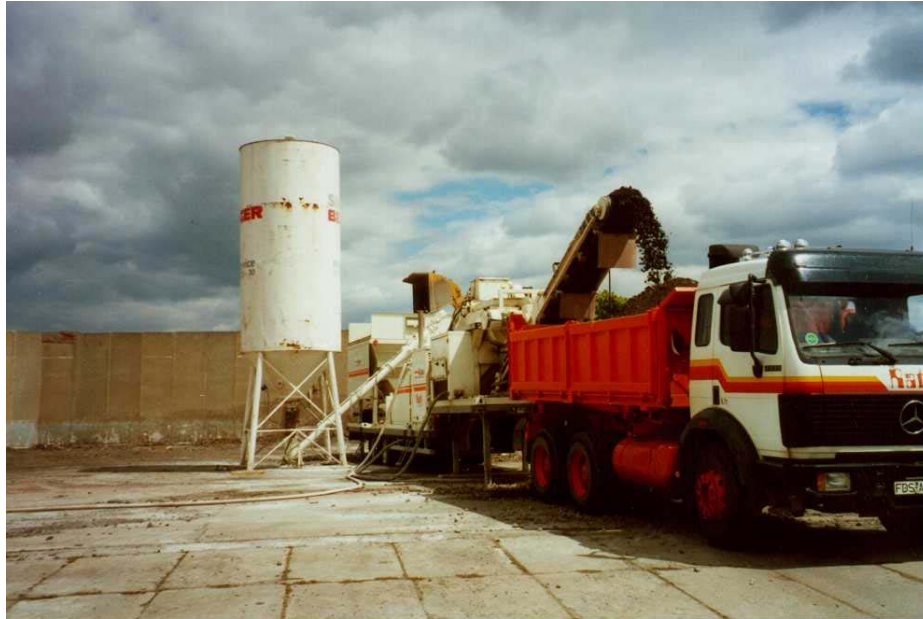
Bild 2525 Wirtgen-Kaltmischanlage KMA 150 in Arbeitsstellung - Verladung von KRC-Mischgut
