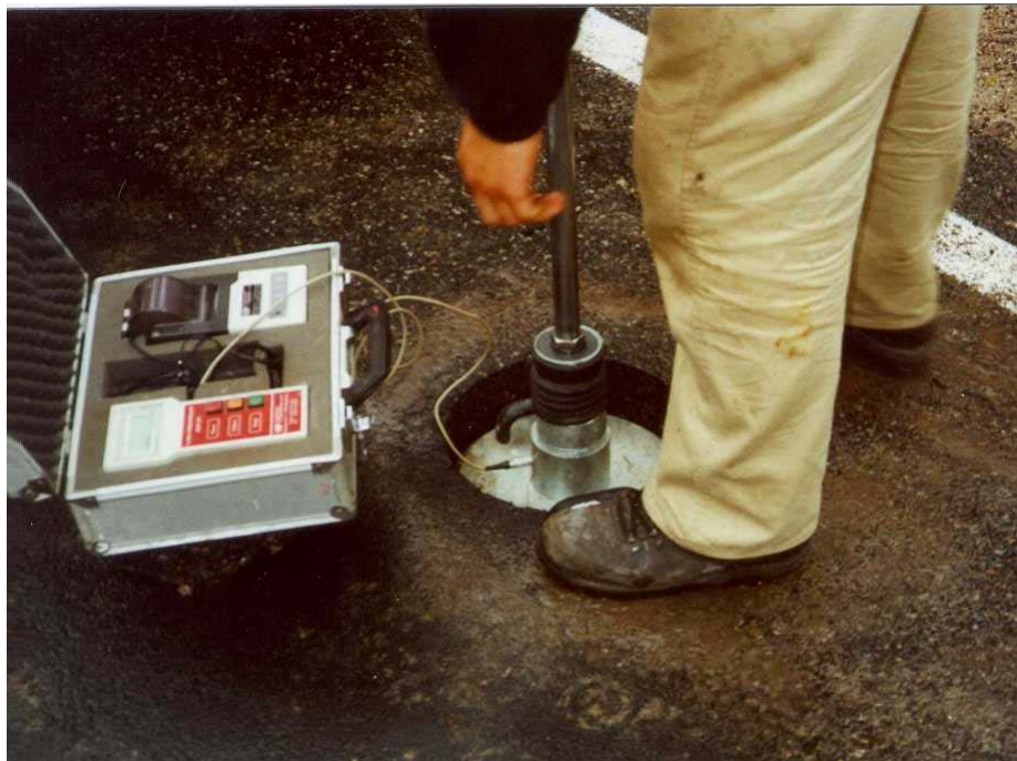
Bild 55 Tragfähigkeitsmessung mit Leichtem Fallgewichtsgerät in Bohrloch - Detail - Registrierung der Messwerte
