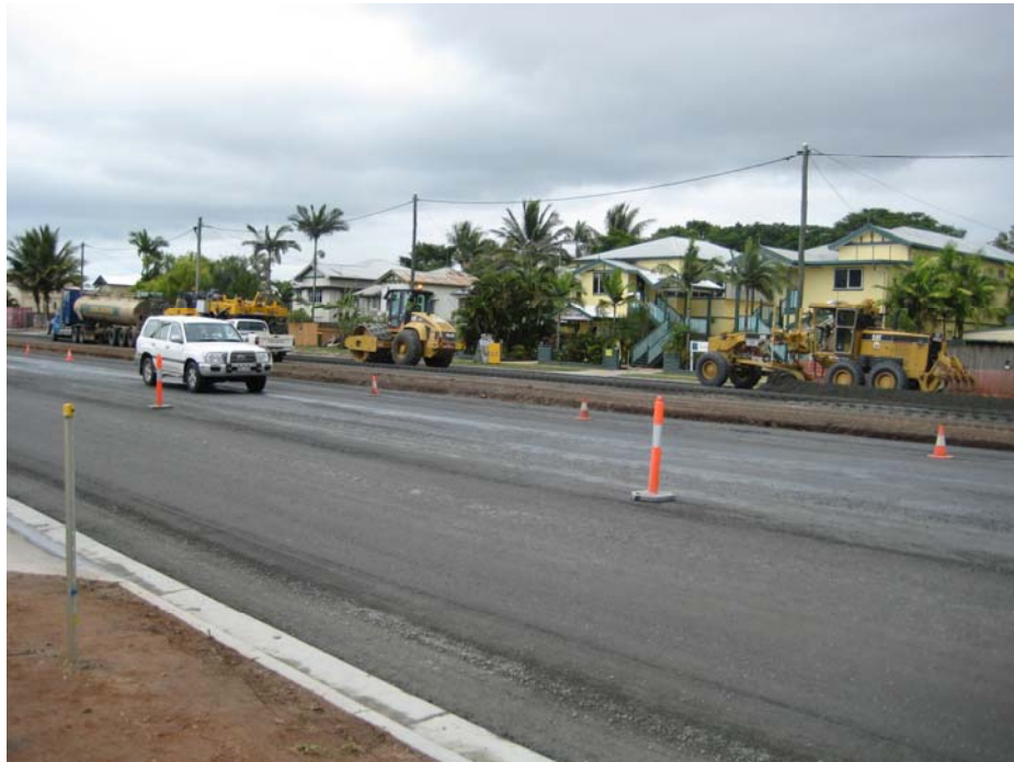
Bild 2020 Einbau von KRC-Mischgut -- Profilierung mittels Grader
