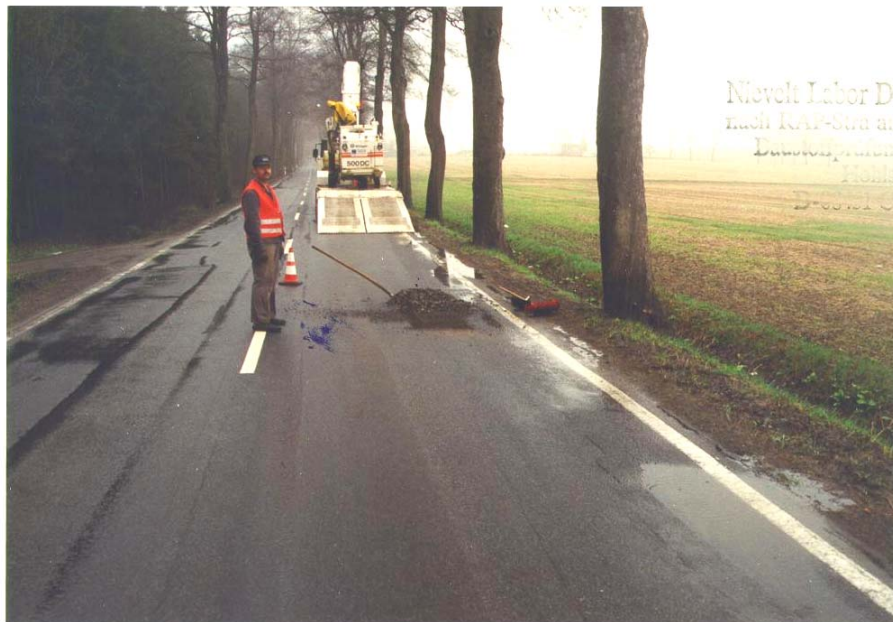
Bild 66 Fräse 500 DC nach Probefräsung verladen, im Vordergrund Probefrässtelle
