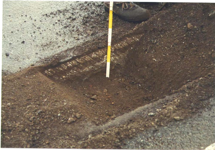
Bild 77 Probefräsung - Messung der Frästiefe, Fräsgranulat aus Mitte der Frässtelle z. T. bereits entnommen
