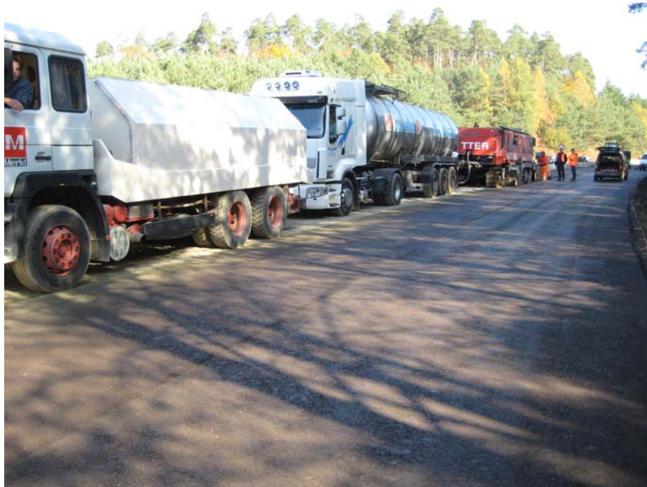
Bild 11 Gerätekomplex für Kaltrecycling in situ - Wassertankfahrzeug, Tanker für Bitumenemulsion und Recycler WR 4200
