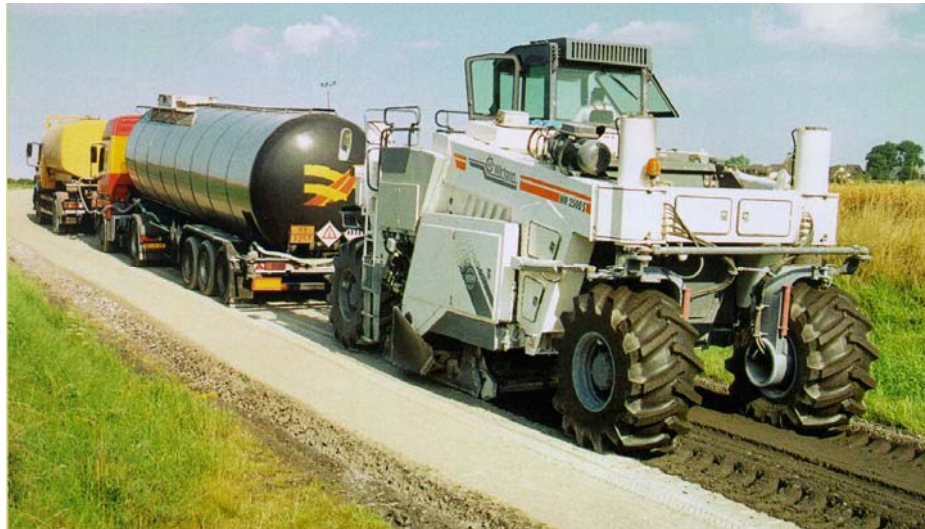
Bild 1818 Wirtgen-Fräsrecycler WR 2500 S im Einsatz -- Reifenabdrücke im KRC-Gemisch
