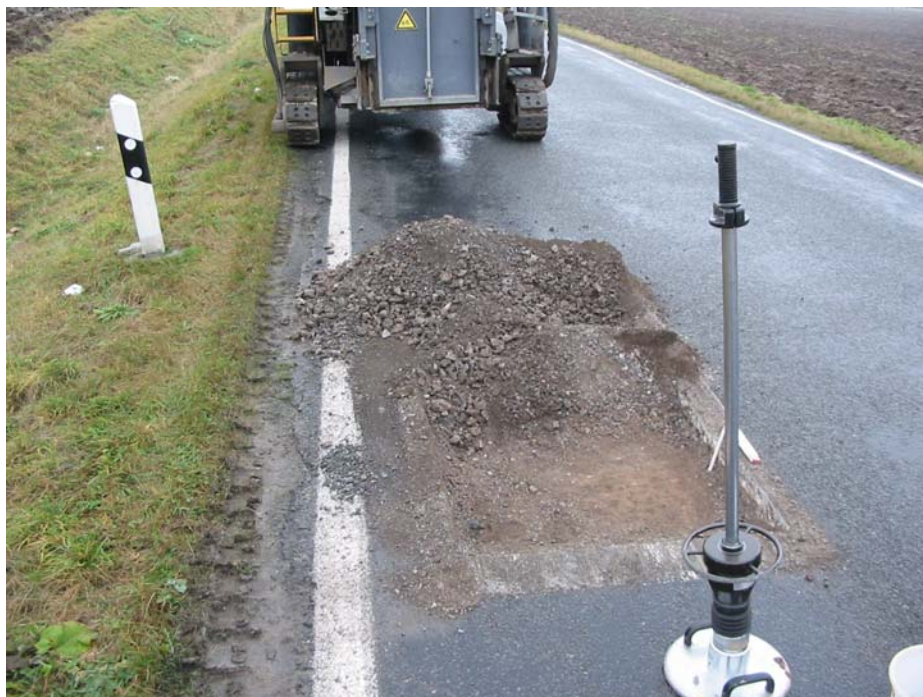
Bild 88 Probefräsung - Fräsgranulat aus Frässtelle z. T. entnommen, ungebundene Unterlage für Tragfähigkeitsmessung vorbereitet, im Vordergrund Leichtes Fallgewichtsgesät
