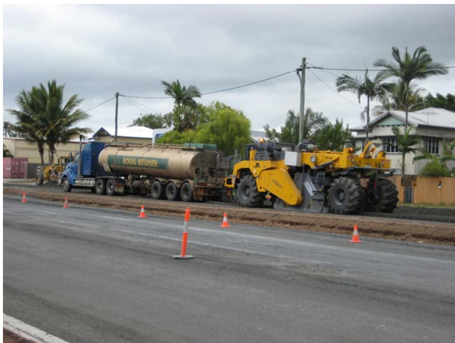
Bild 1919 Wirtgen-Fräsrecycler WR 2400 - Einsatz bei der Verarbeitung von Schaumbitumen
