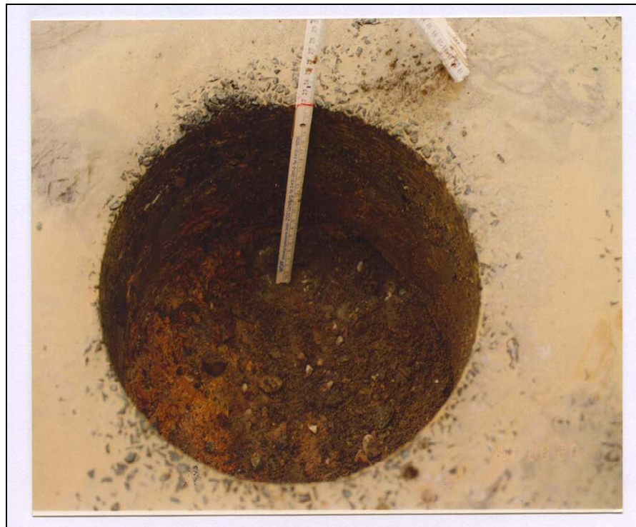
Bild 33 Bohrloch \varnothing 340 mm zur Erfassung der Dicke des gebundenen Oberbaues und zur Tragfähigkeitsmessung auf der ungebundene Tragschicht in ca. 20 cm Tiefe
