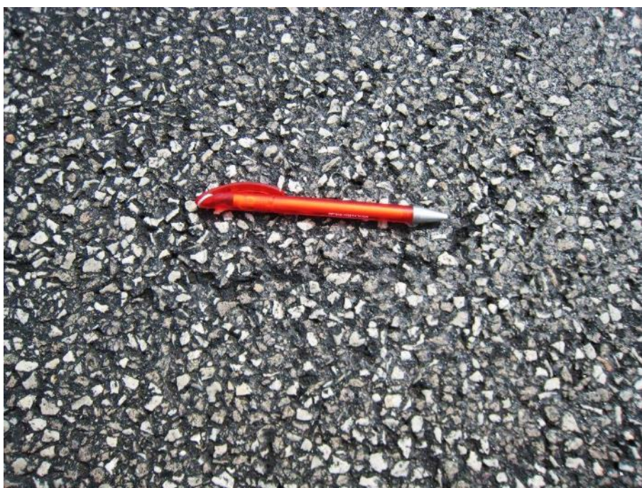
Bild 2: Konservierung von Asphalt auf der A 8 nach 8 Monaten 2012
