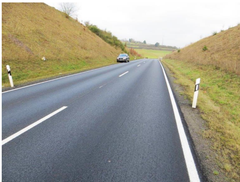
Bild 8: DSK-mAZ auf der B 270 Erfenbach 2014
