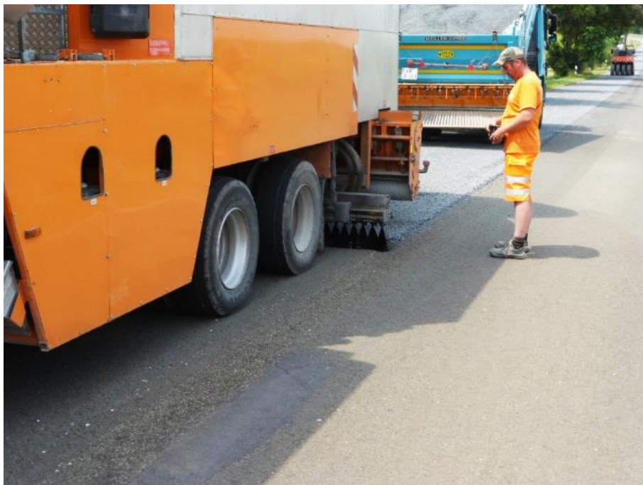
Bild 6: B 270 Herstellen der bitumenhaltigen Zwischenschicht
