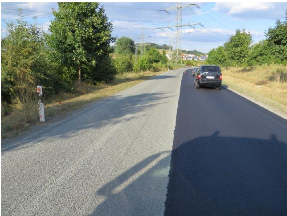
Bild 7: DSK-mAZ auf der B 270 Erfenbach erste Lage DSK auf bitumenhaltiger Zwischenschicht 2014
