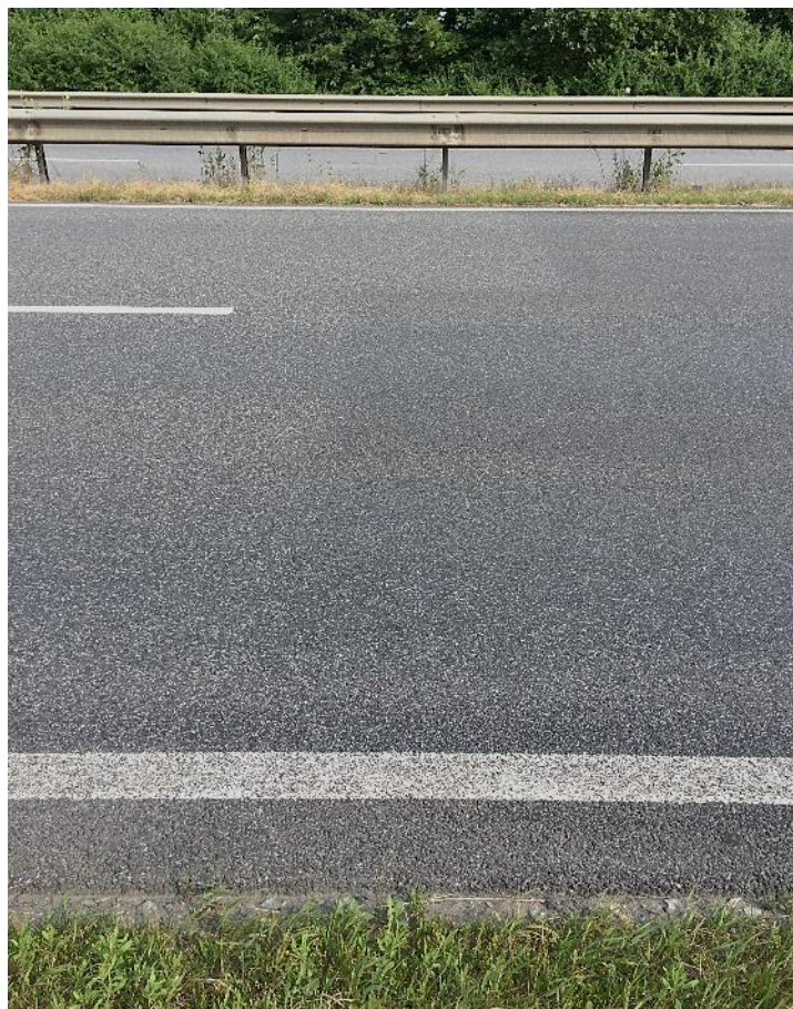
Bild 3: Konservierung von Asphalt auf der B 50 Ellern nach 4 Jahren 2016 (links nicht konserviert, rechts konserviert)
