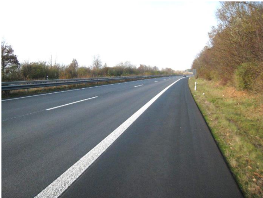
Bild 1: Konservierung von Asphalt auf der A 8 nach 2 Monaten 2012
