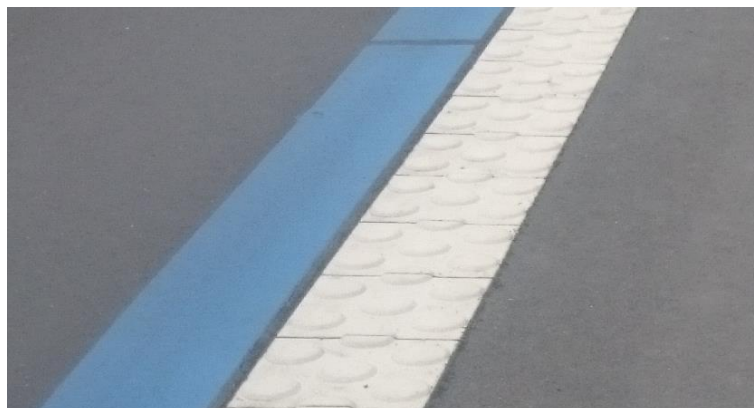
Abbildung 7: Trennung RSV zum Fußverkehr über taktile Elemente Bsp.: e-Radschnellweg in Göttingen (Foto: R+T)
