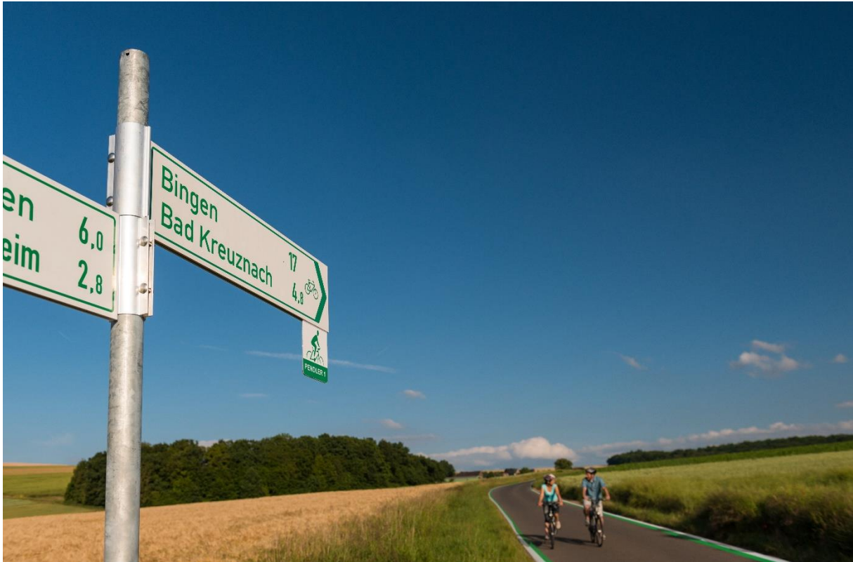
Abbildung 9: HBR-Pfeilwegweiser mit PRR-Routenlogo als Einschubplakette Foto: Dominik Ketz; Montage Beckmann Mediendesign
