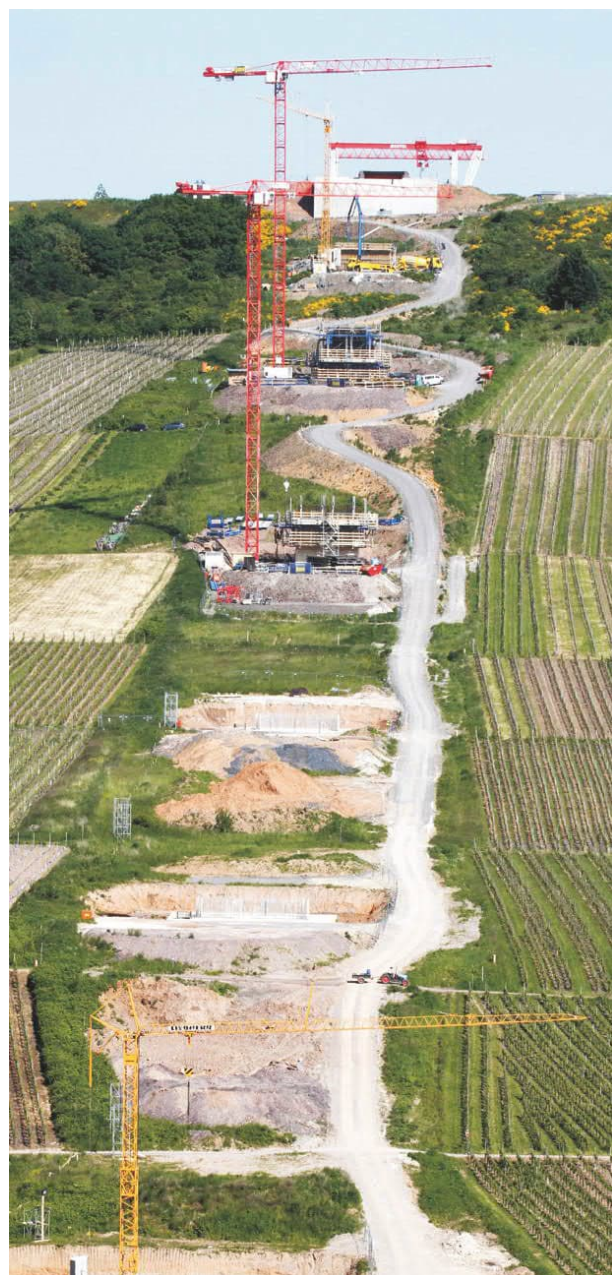
Blick auf die Baustelle (2013)
