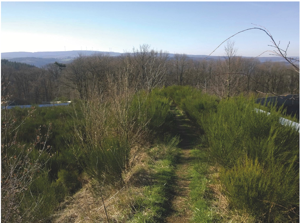
Grünbrücke fertiggestellt noch vor Verkehrsfreigabe
