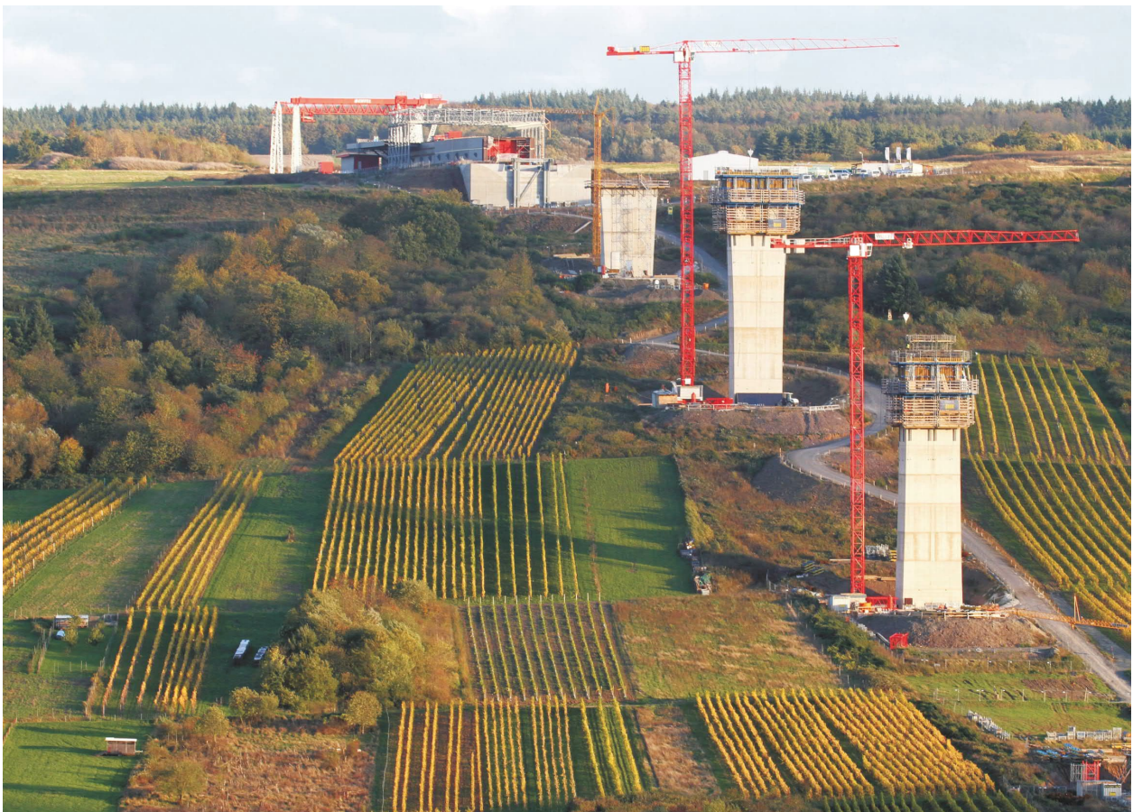
An den Spitzen der ersten Pfeiler sieht am im Oktober 2013 die Selbstkletterschalung
