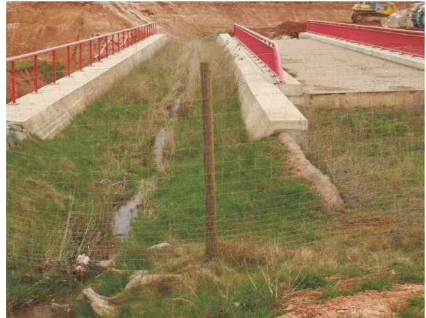
Brücke „Pinricher Graben“
