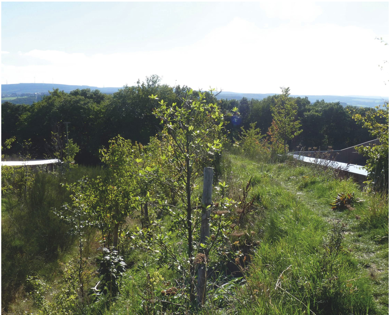
Blick auf die Grünbrücke „Graacher Schanze“ mit dem Wanderweg; Foto: Dr. M. Hermann
