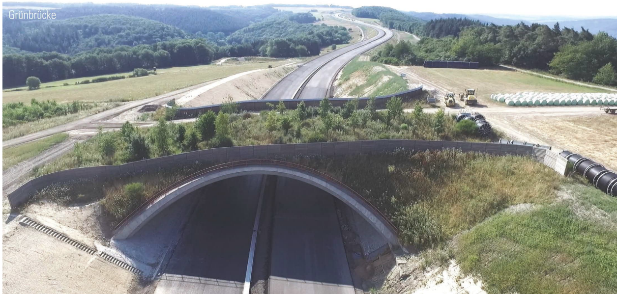
Grünbrücke in der Bauphase der Strasse
