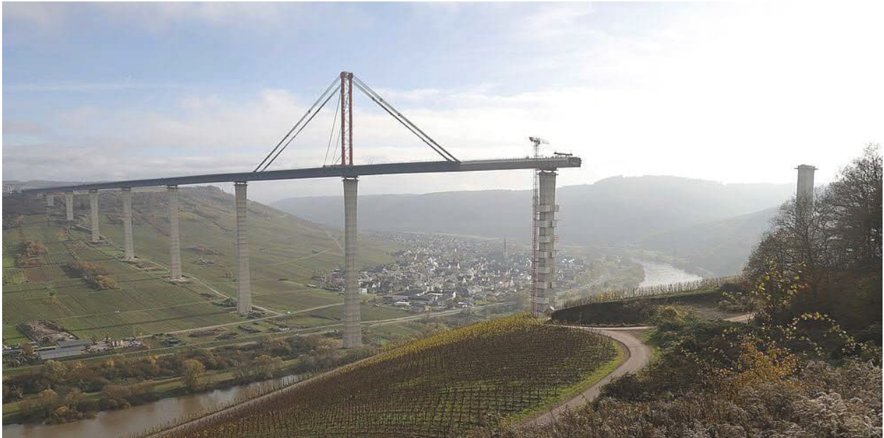
Hochmoselbrücke, 11 Vershub (November 2017)
