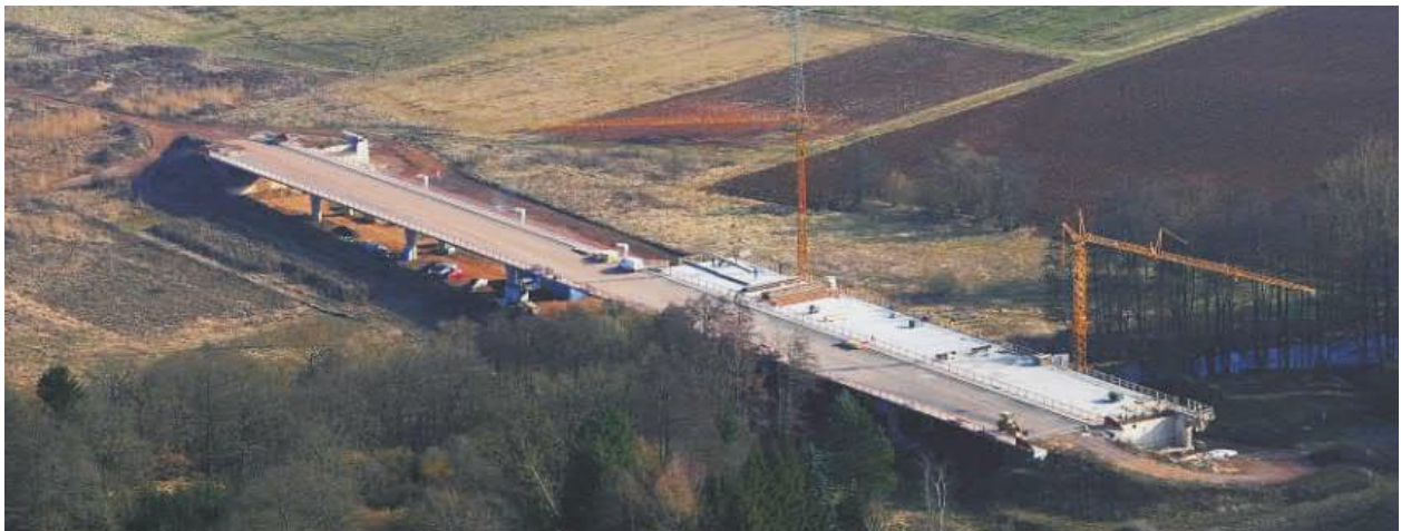
Talbrücke Lieser im Bau (2011)
