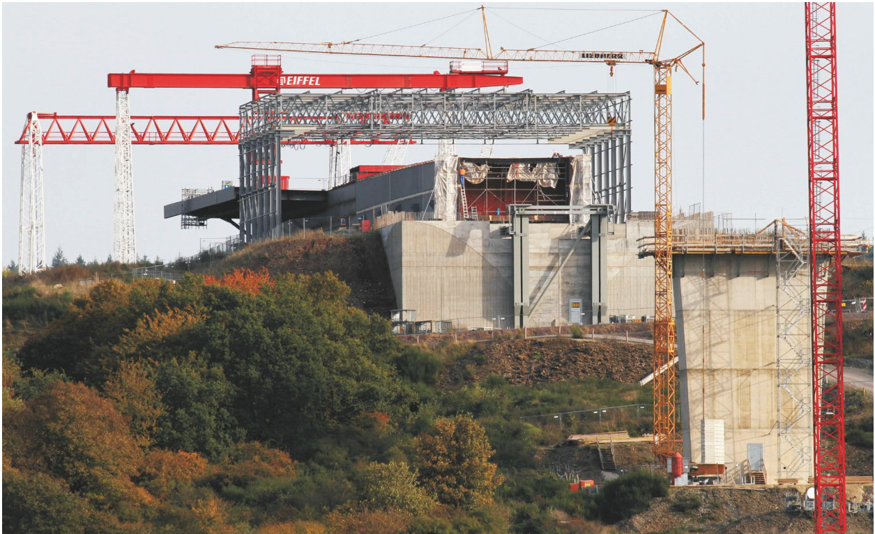
Blick auf den Montageplatz Im Vordergrund Pfeiler 10
