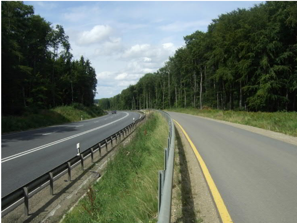
Abbildung 2: B 51 zwischen Helenenberg und Meilbrück nach dem Ausbau.
