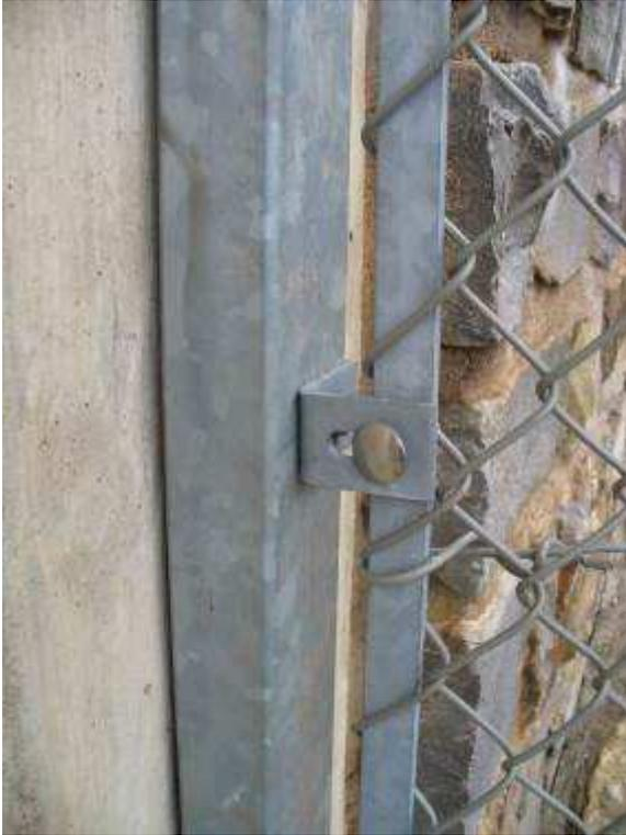
**Abb. 52: Eine solche Anbindung des Zaunflechts an den Untergrabungsschutz und die Wände ist baumrardersicher.**
