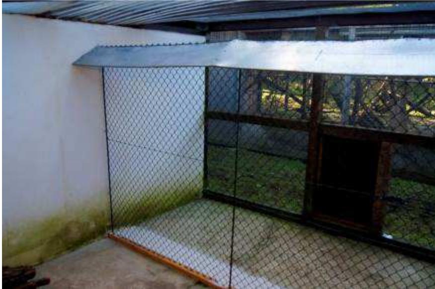
Abb. 27: Vollbild Zaun Grundtyp A 60 mit Bodenbefestigung und Blechüberhang, 30 cm
