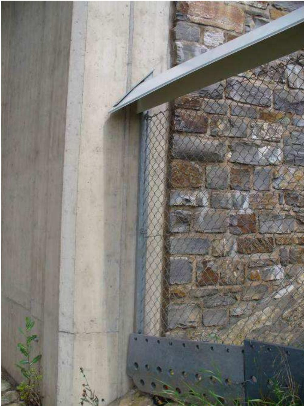
**Abb. 55: Lücken im Sockelbereich in Ecken, wie hier, werden von Baumrardern sofort gefunden. Bei baumrardersicheren Zäunen müssten die Wandanschlüsse mit glatten Platten verkleidet werden. Außerdem können sich Baumrarder in diesem Fall durch den Spalt unterhalb des Überkletterschutzes zwingen.**
