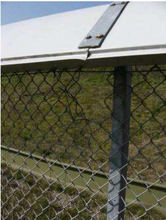
**Abb. 54: Loch unterhalb des Überkletterschutzes an der A60. Für Baumrarder schwer zu finden.**
