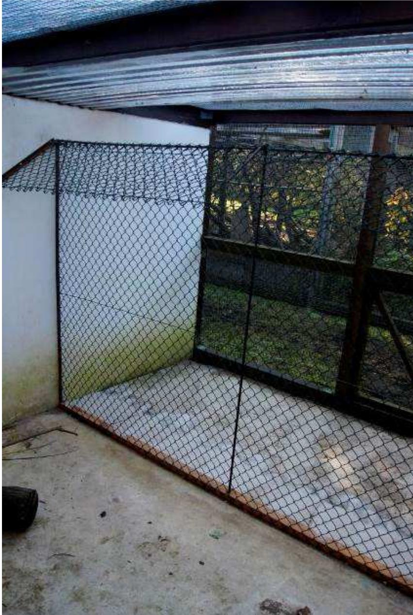
**Abb. 26: Vollbild Zaun Grundtyp A 48 mit Bodenbefestigung und Überhang 50 cm, sowie Sandstreifen auf der Außenseite.**
