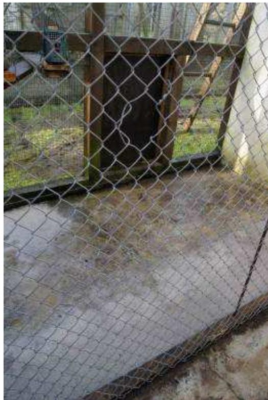
Abb. 32: Zauvariante E-Litze – zerstörte Masche in 1,2 m Höhe
