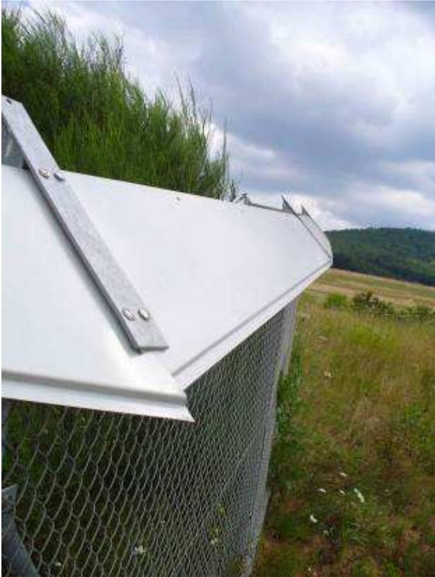
**Abb. 56: Kanten und Überstände an einem Überkletterschutz. Baummarder genügen diese Strukturen, um sich hochzuziehen.**
