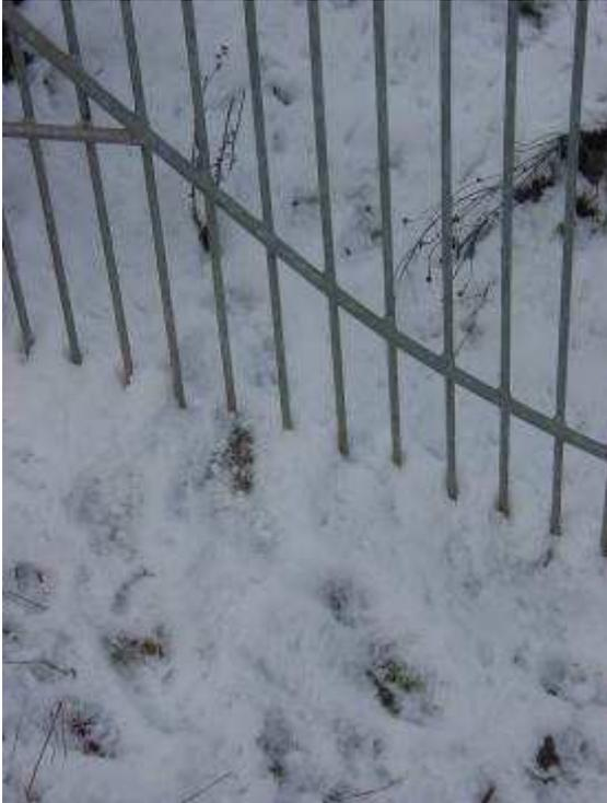
**Abb. 53: Stabgitter an der A60, bei dem ein kleiner Marder hindurch schlüpfte.**
