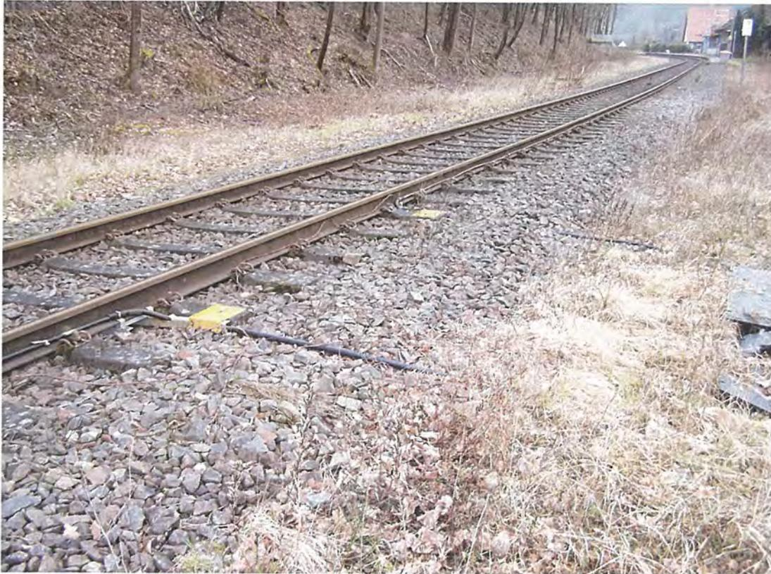
**Strecke 3300: LWL-Kabel im Schienenfuß bahnlinks – Ausfädelung zum GSM-R-Mast**
