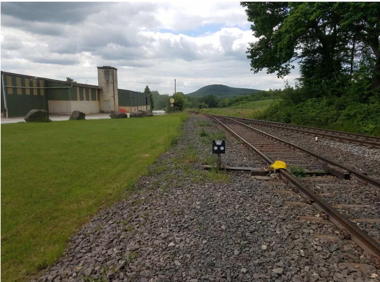
Blick Richtung Westen auf die Gleissperre und die Anschlussweiche im Hintergrund. Am rechten Rand der Wiese ist das neue Gleis 2 geplant.
