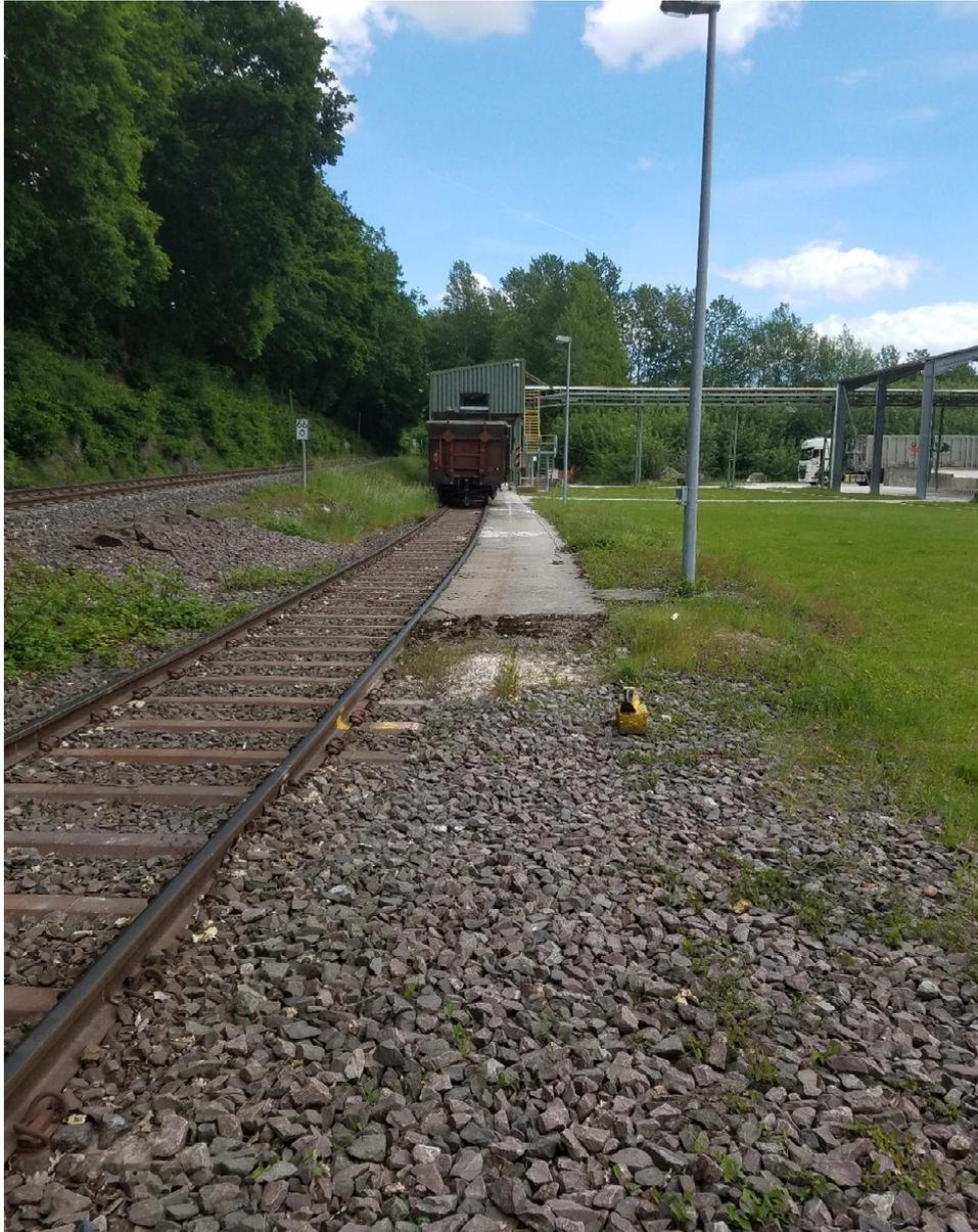
Blick Richtung Osten auf die vorhandene Verladeanlage. In den vorhandenen Gleisbogen des Gleis 1 ist die neue Weiche 1S geplant. Der Weichenanfang liegt etwa am Beginn der Betonfläche.
