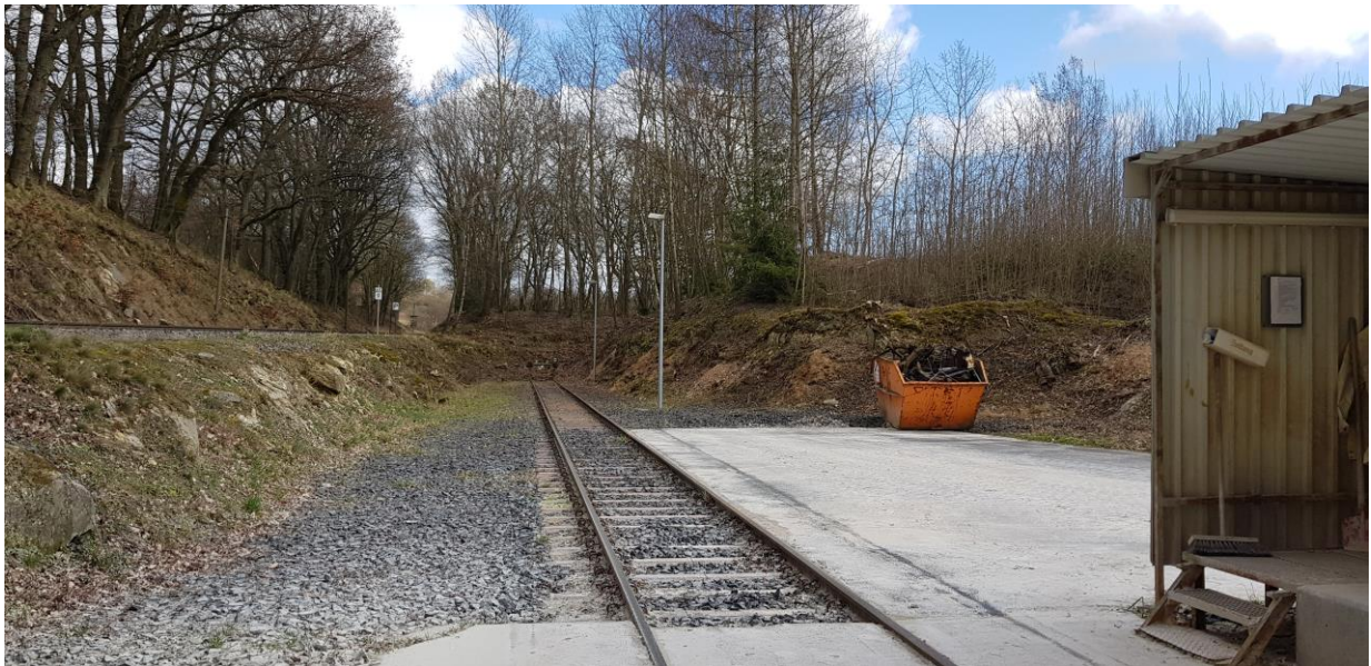
Foto 1: Vorhandenes Verladegleis und links angrenzend das Streckengleis. Die Verlängerung erfolgt in den Bestand am Ende des heutigen Verladegleises.
