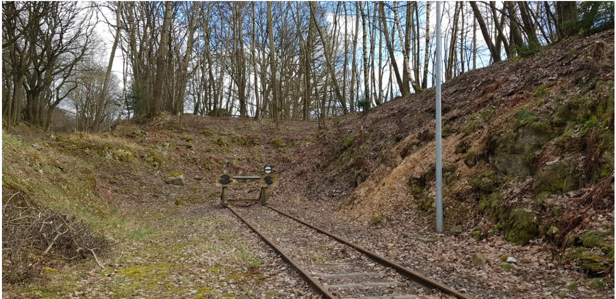
Foto 2: Östliches Ende des heutigen Verladegleises. Durch das Projekt erfolgt eine Verlängerung von ca. 95 m nach Osten in den angrenzenden Gehölzbestand
