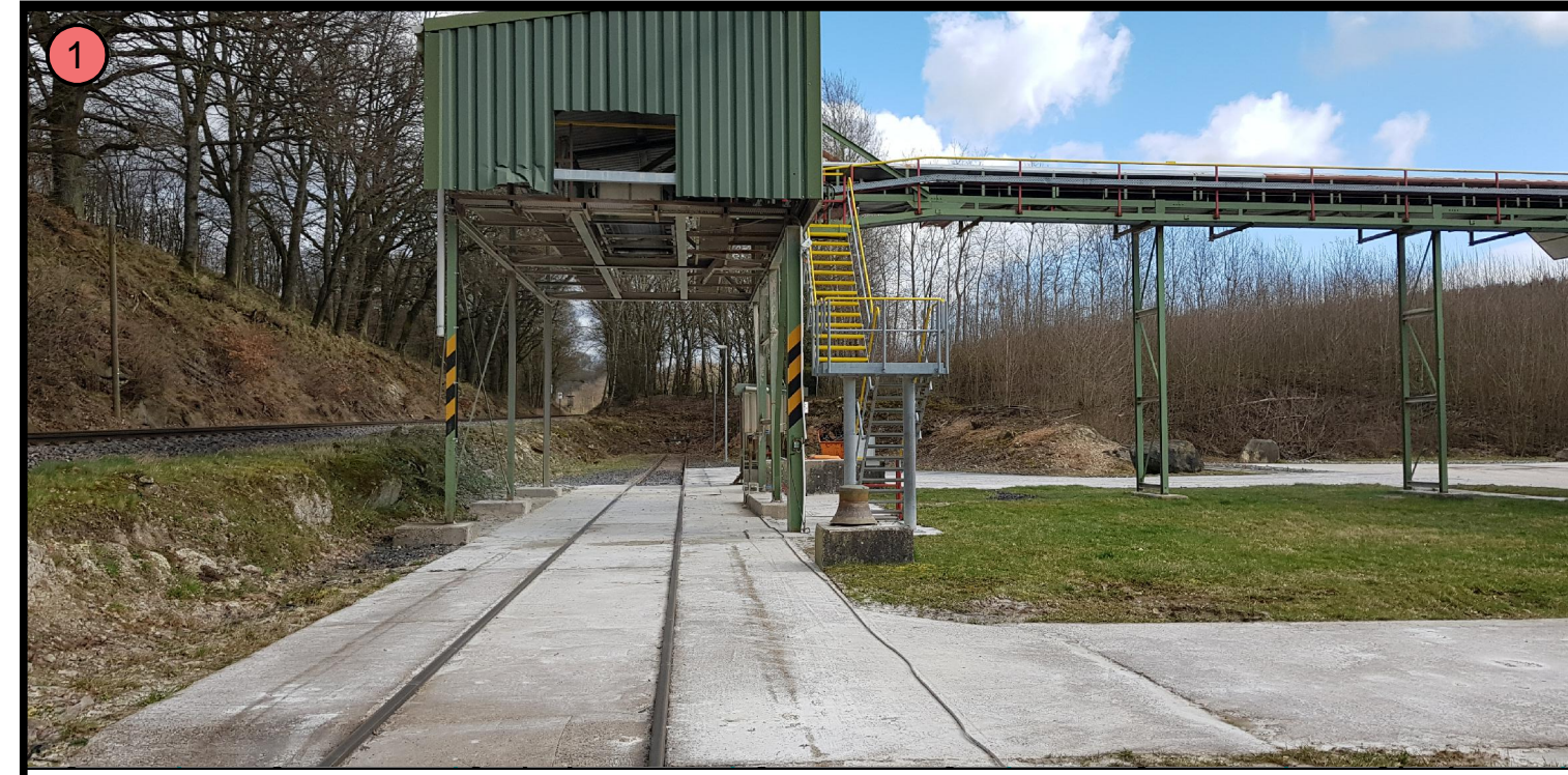
Bestehende Verladestation im Tontagebau "Pfeul"
