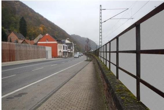
Abbildung 5.6: Geländer mit schematischer Geländerausfüllung (grau)
