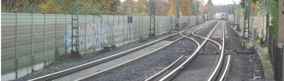
Abbildung 5.4: Schallschutzwand, Höhe 2 m über SOK
