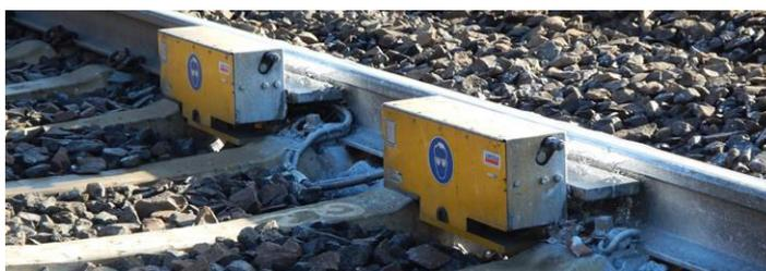
Abbildung 5.7: Schienenschmiereinrichtung
