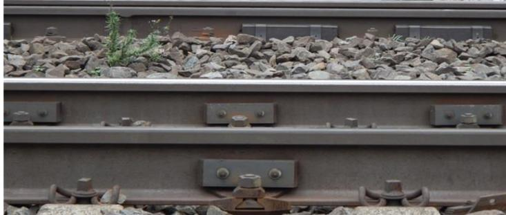
Abbildung 5.2: Schienenstegdämpfer unterschiedlicher Bauart in Koblenz
