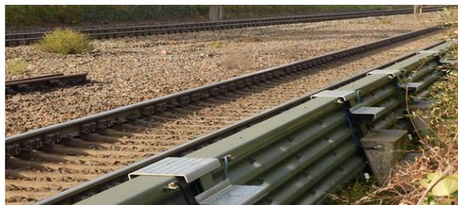
Abbildung 5.5: Niedrige Schallschutzwand, Höhe 55 cm über SOK
