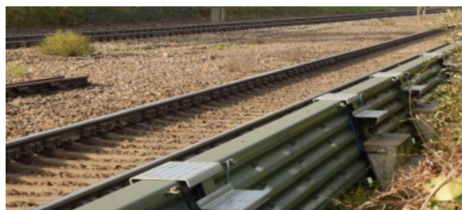
Abbildung 5.5: Niedrige Schallschutzwand, Höhe 55 cm über SOK
