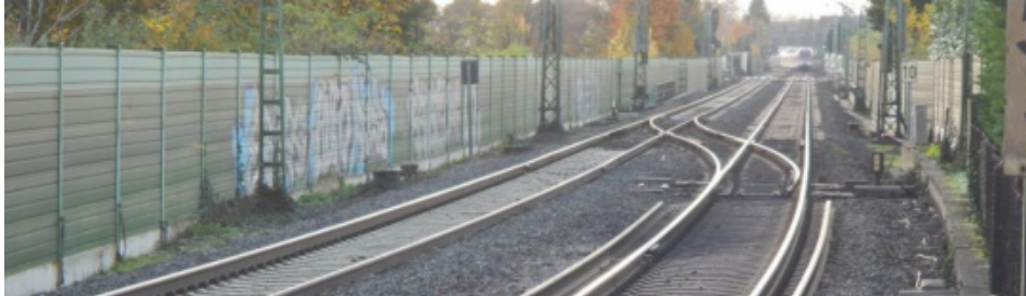
Abbildung 5.4: Schallschutzwand, Höhe 2 m über SOK
