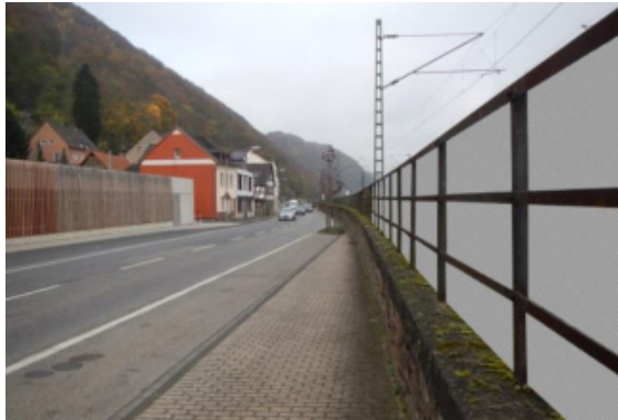
Abbildung 5.6: Geländer mit schematischer Geländerausfüllung (grau)
