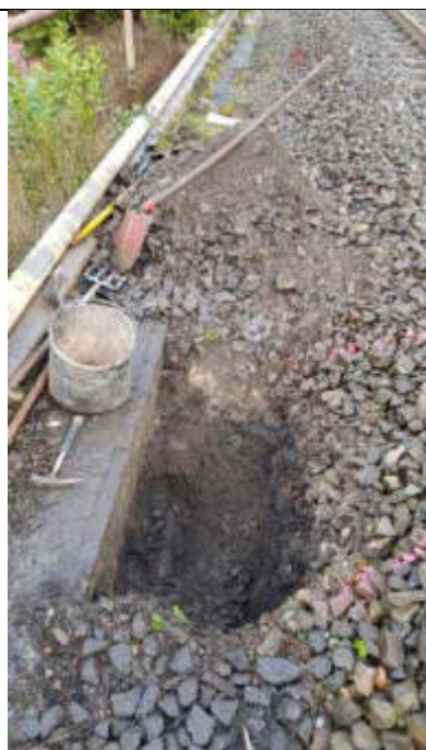
Bild 8: Sch 1002, offener Schurf
