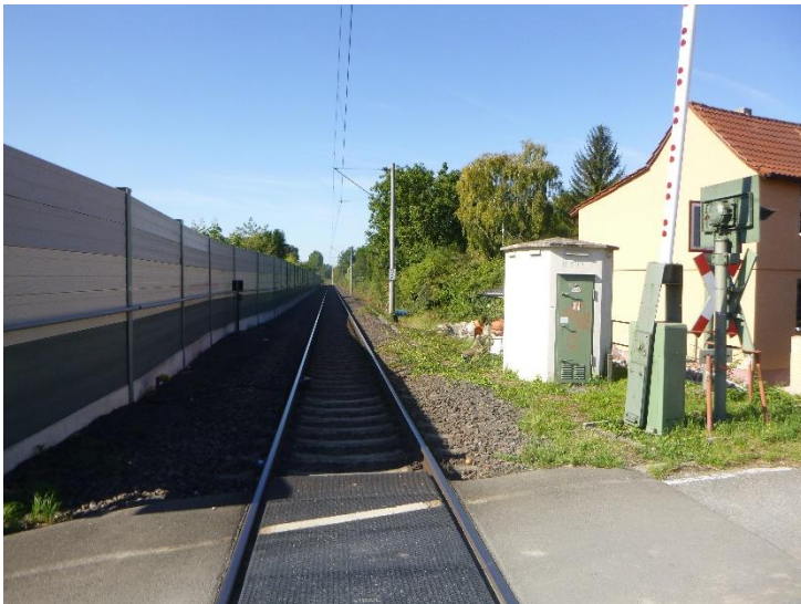
Abbildung 1: Blick vom BÜ in südliche Richtung. Die Lärmschutzwand bewirkt eine starke Verschattung der Bahnlinie. Das Schalthaus im II. Quadranten wird zurückgebaut.
