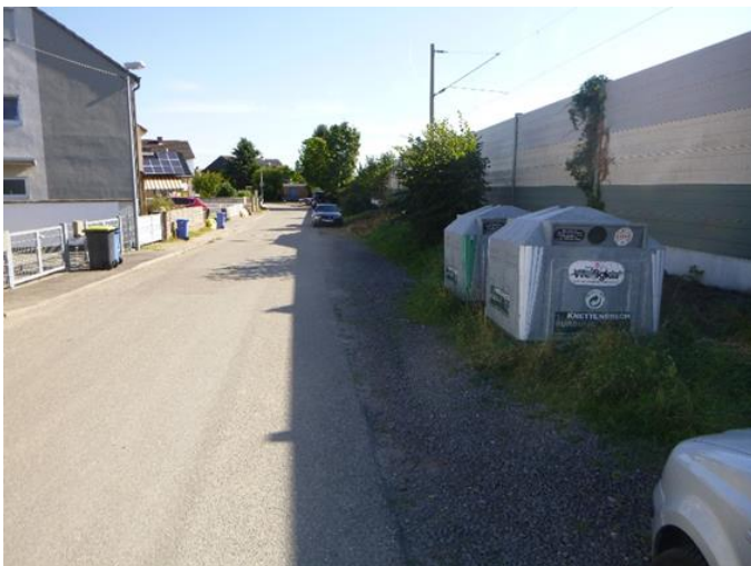
Abbildung 4: Die Fläche zwischen Lärmschutzwand und Straße ist als BE-Fläche vorgesehen.
