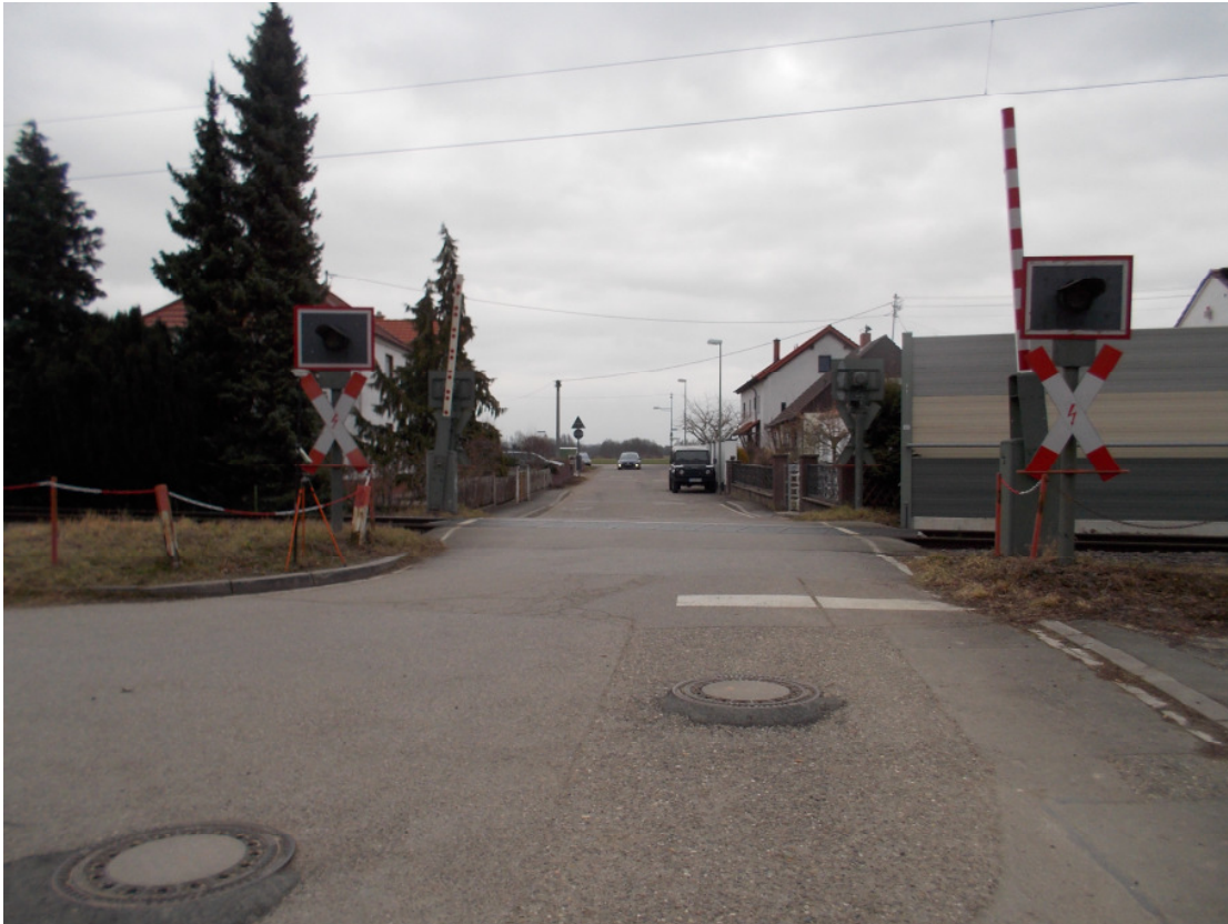
Abbildung 4: BÜ km 3,270 Blickrichtung Osten
