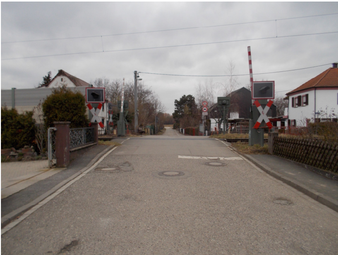
Abbildung 5: BÜ km 3,270 Blickrichtung Westen
